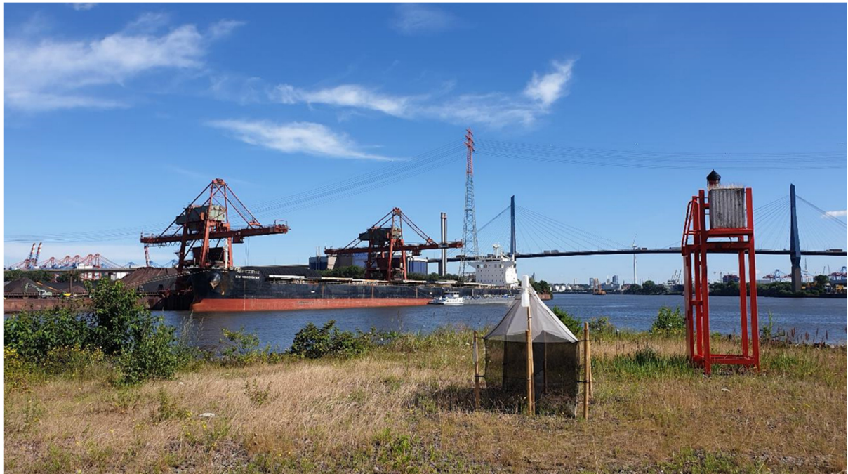
Abbildung 2: Untersuchungsstandort Nr. 5 mit Blick auf die Köhlbrandbrücke
