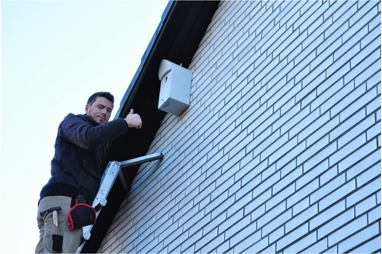
Abbildung 8: Projektleiter Simon Hinrichs bei der Montage.
